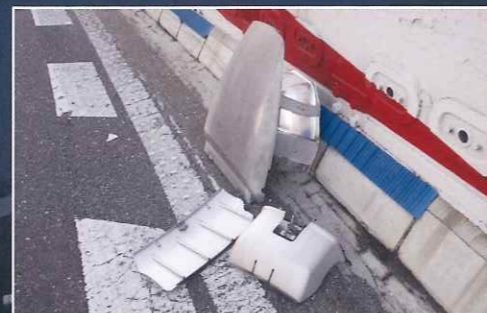
落下し破損した照明灯具
