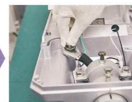
照明灯具本体側にらく防くん®を六角ボルトでしっかり固定する。
