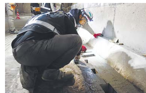
PcAで製作したふたを設置
