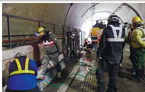
天端の撤去作業
