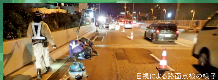
目視による路面点検の様子
