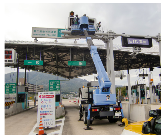
第二阪奈有料道路 道路情報板 LED 交換
